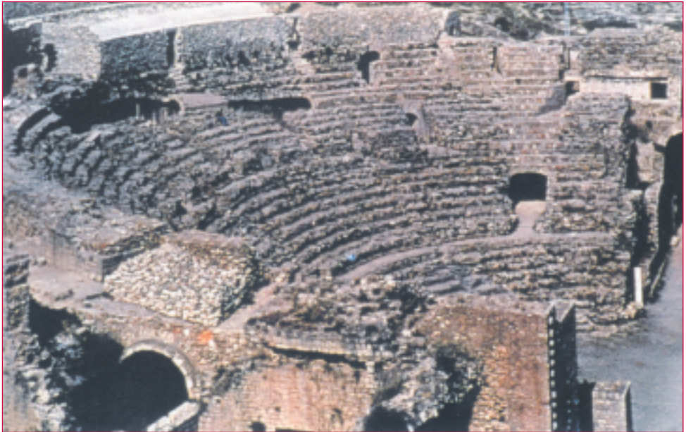
Ruínas do Teatro Romano de Sagunto antes da última “restauración”.
