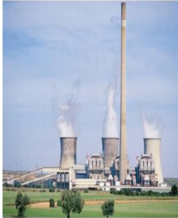
Fotografía de central térmica de carbón en Andorra (Aragón)
