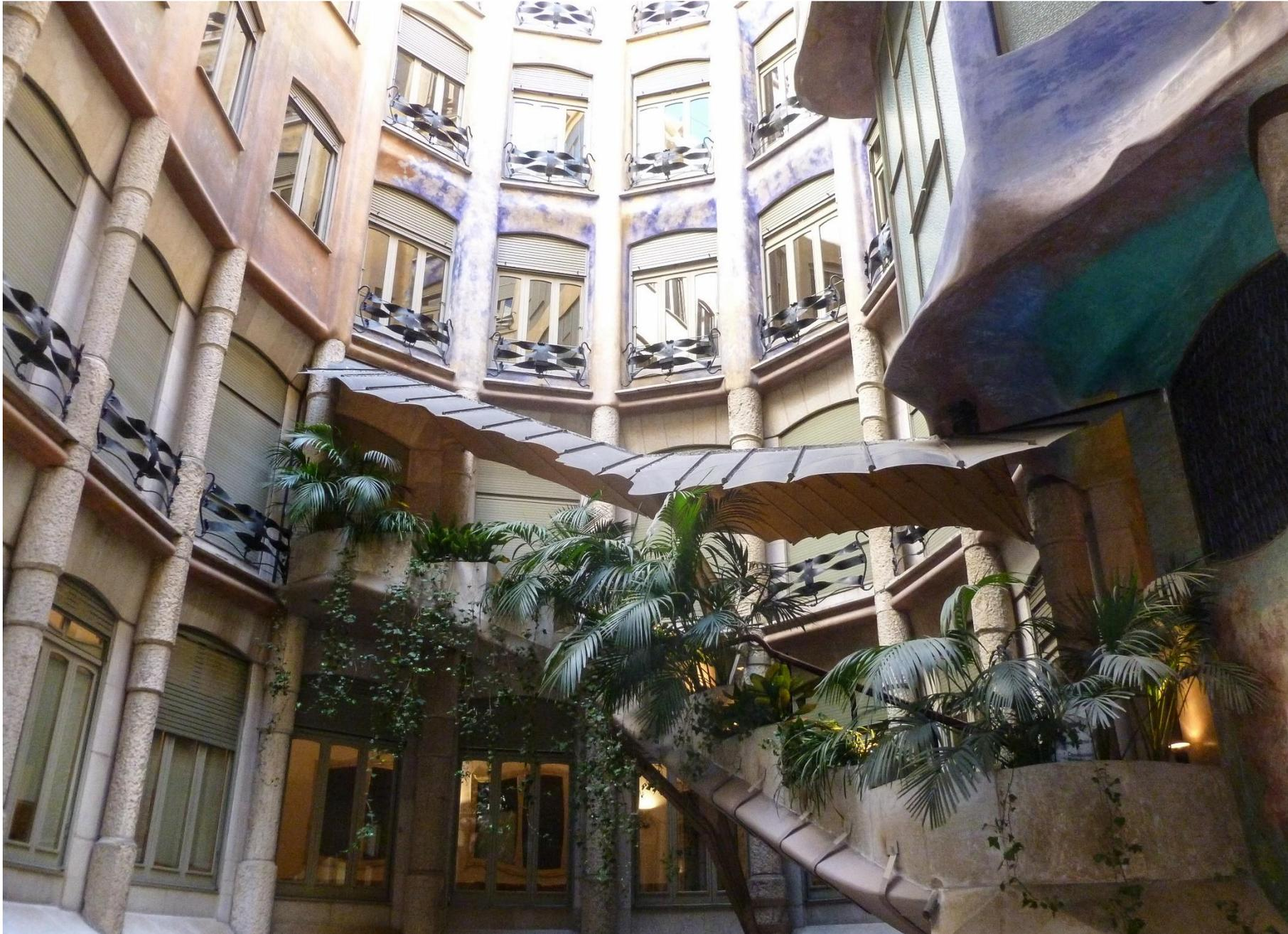
El acceso a las viviendas se articula a través de dos grandes patios de luces, que permiten una amplia iluminación y ventilación para todos los pisos. Así, la cara interna de los pisos presenta una nueva fachada con amplios ventanales y barandillas de hierro, con un sistema de columnas cilíndricas en los dos primeros pisos, sustituidas por mampostería revocada en los superiores.
