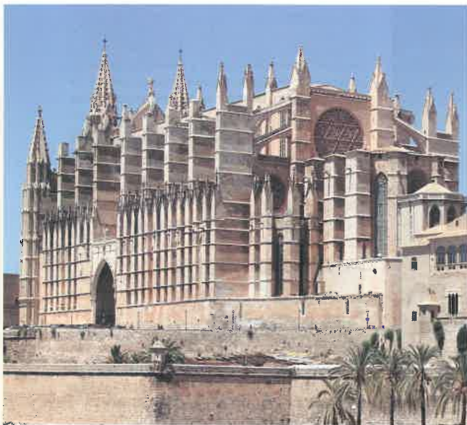
Catedral de Palma (siglo XIV), Baleares. Es de tres naves sin girola. Las grandes dimensiones de la nave central explican los numerosos arbotantes y estribos del exterior.
