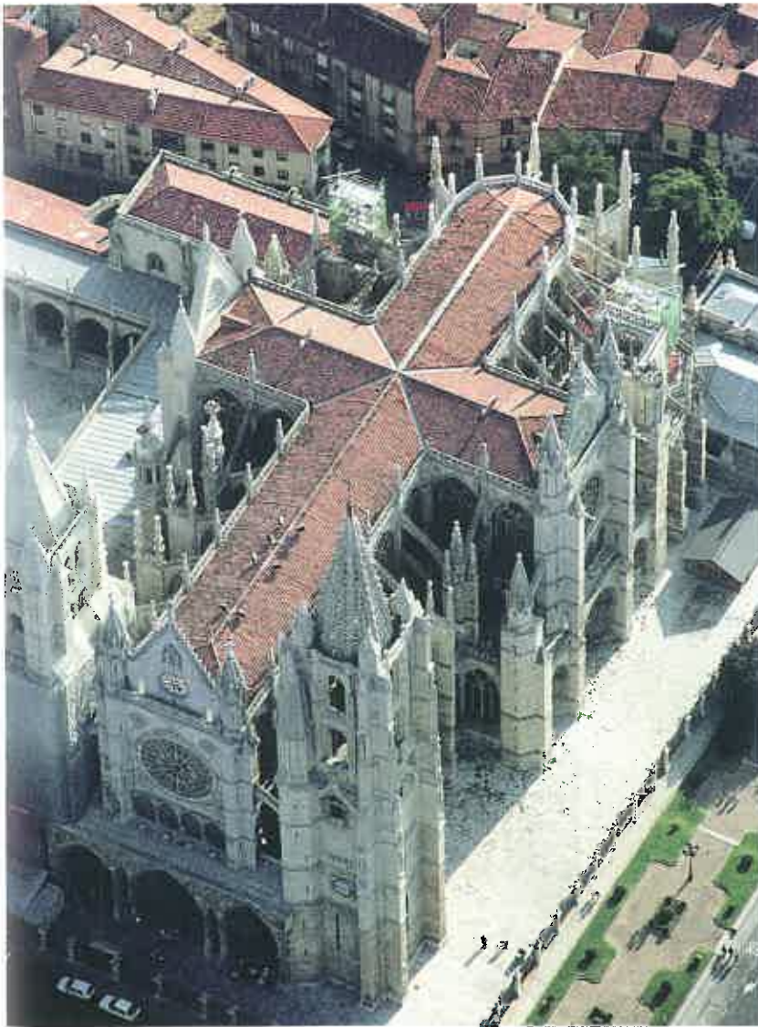
Catedral de León (siglo XIII). Es el edificio en el que mejor se observa el más puro estilo francés. Presenta tres naves, crucero y girola, con una cabecera muy grande. Sus vitrales son de los mejores de Europa y proporcionan una iluminación de gran belleza.
