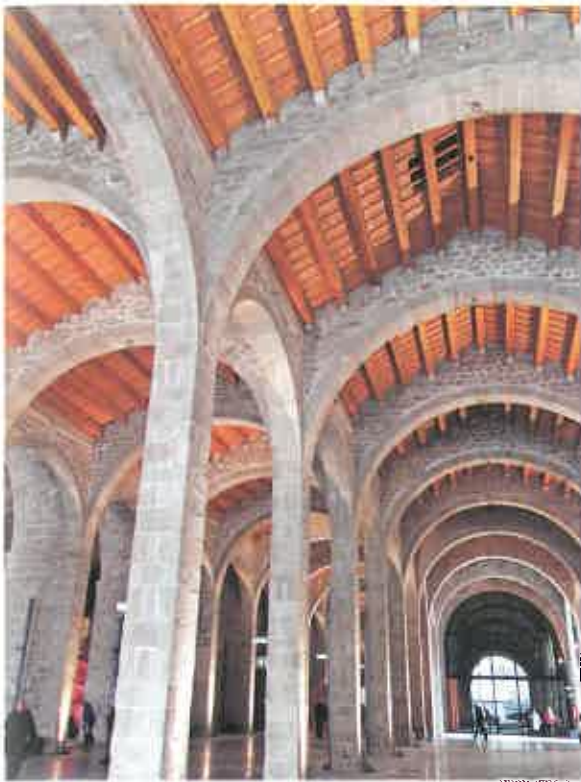
Interior de las Atarazanas (siglo XIII), Barcelona. Se aprecia una sucesión de naves sostenidas por pilares de piedra, con una cubierta de doble vertiente en madera.
