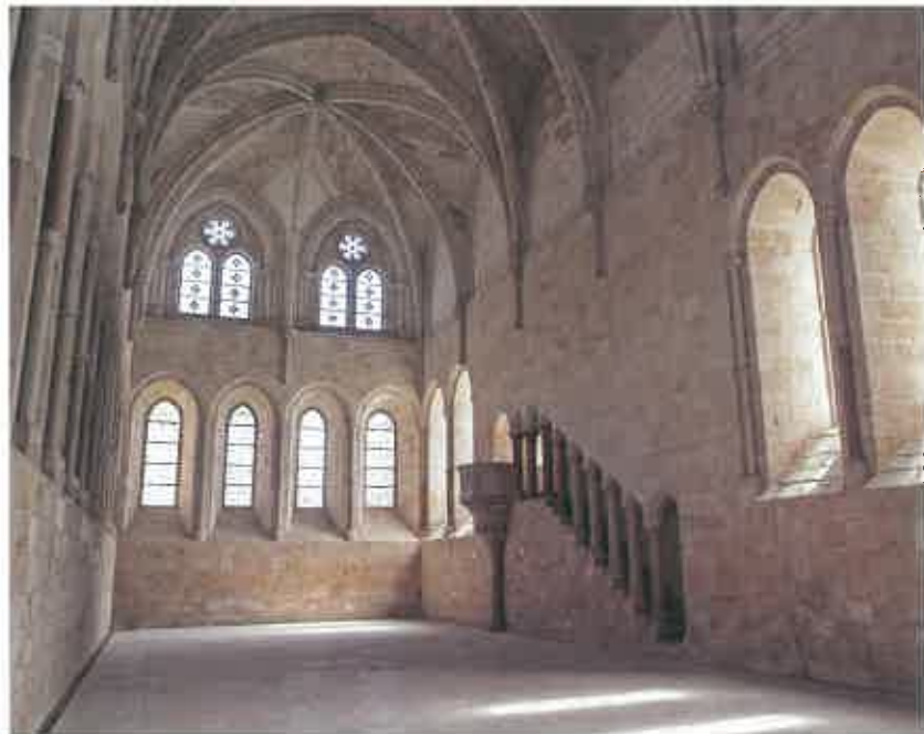
Refectorio del monasterio de Santa María de Huerta (siglo XIII), Soria. Destaca la pureza arquitectónica cisterciense, sin decoración, y el púlpito con su acceso en el muro.
