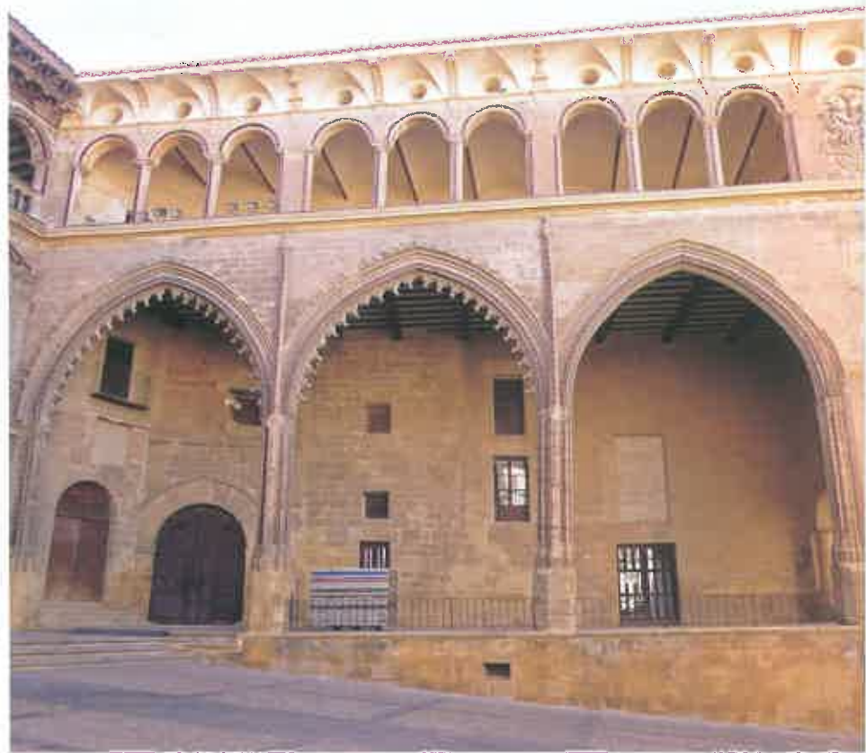
Lonja de Alcañiz (siglo XV), Teruel. Presenta un amplio y elevado pórtico con tres grandes arcos apuntados. Esta estructura gótica tuvo ampliaciones en los siglos XVI y XVIII.
