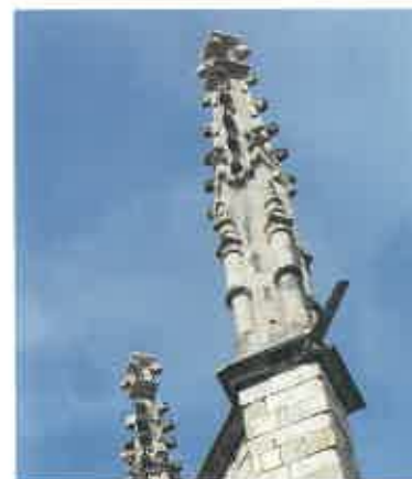
Detalle de los pináculos de la catedral de León . Los pináculos tienen esencialmente una función decorativa que potencia la sensación de verticalidad del edificio.
