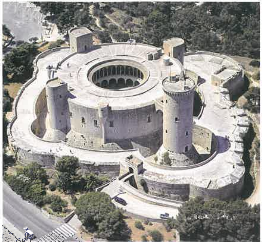
Castillo de Bellver (siglo XIV), Palma. Es el único en España de planta circular. Fue construido para albergar a los miembros de la corte de Jaime II. Consta de muralla, foso, torres y patio central con doble arquería de dos pisos.
