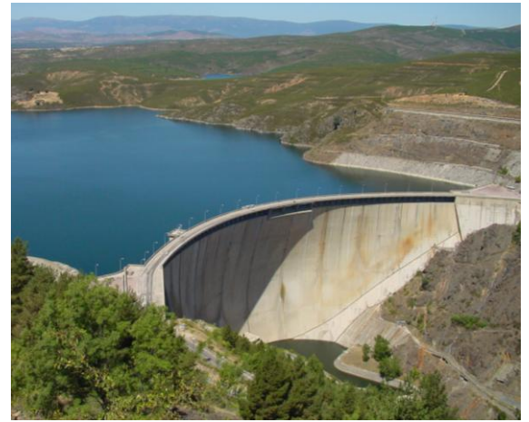
Foto de la central hidroeléctrica.
