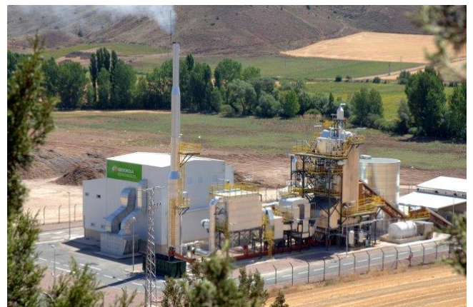
Foto de una central de biomasa en Corduente.
