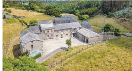
Vista de la aldea que podría ser reconvertida en casa rural en Oroul.
