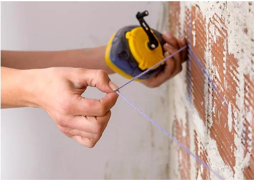
.- Para colocar las cajas de mecanismos en una determinada posición **se toman referencias.**
