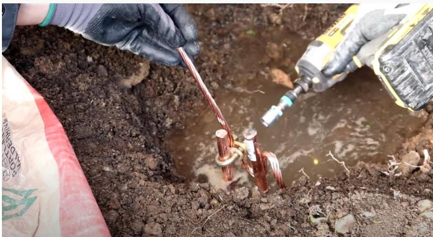
Colocación de un cable de puesta a tierra en una zanja de cimentación de un edificio.
