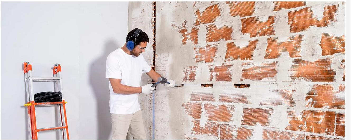
4.- ... o mediante una rozadora fresadora (Nota: en las imágenes no se ve el sistema de aspiración de polvo)
