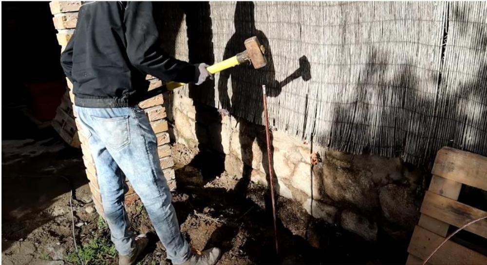
Unión del cable de puesta a tierra con la pica.
