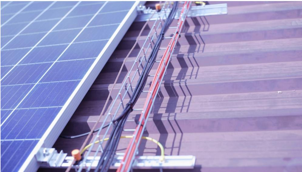
El agrupamiento de polos es una medida de seguridad que rebaja notablemente el efecto de un eventual cortocircuito entre 2 conductores. (Foto cortesía de SPV Sistemas).
