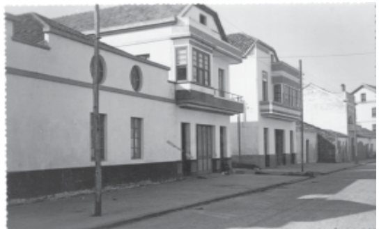
Anos 50. Divísanse os edificios onde actualmente se ubica a empresa de seguros MAPFRE e a oficina de Correos.
