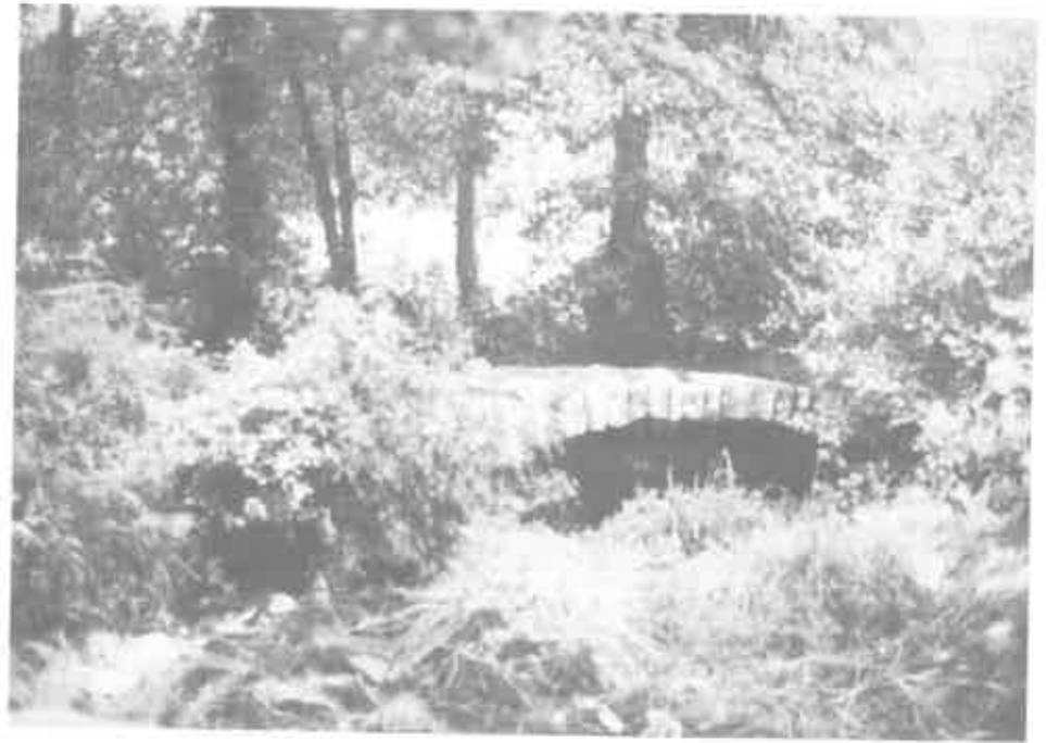
Calzada e ponte romano preto do Castro Lupario no noso Concello.
