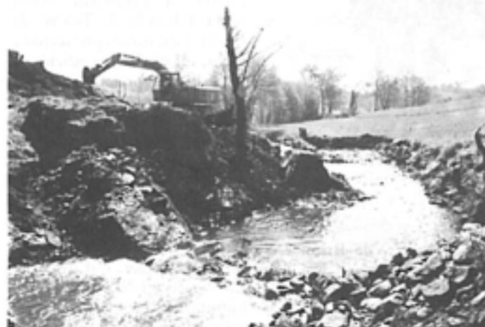
obrigado transporte escolar. Estas obras nos accesos ó novo Colexio esixiron un importante desmonte en Forxán onde se tivo que cortar totalmente unha curva que impedia o paso dos autobuses.
