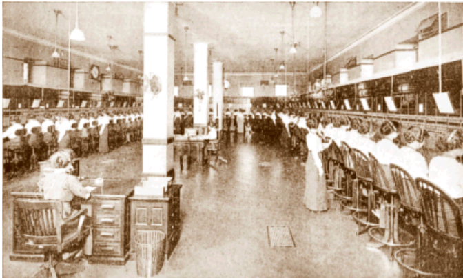
La conexión en las centralitas se realizaba antes de forma manual. Antigua foto de una gran central telefónica de la ciudad de Nueva York, donde se pueden ver a las operadoras atendiendo a los abonados telefónicos. En la actualidad, esto se consigue por medios electrónicos sin necesidad de intervención humana.
