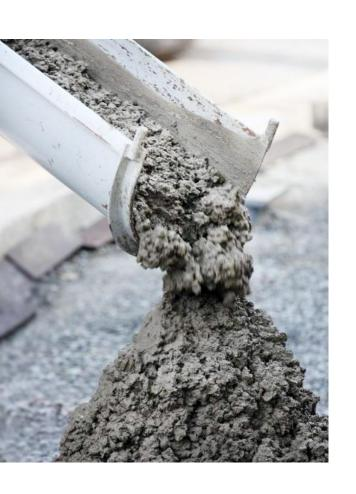
b) El <u>hormigón</u>: mezcla de arena, cemento, agua y grava que se endurece con el tiempo; es económico, duradero, muy resistente a la compresión y poco resistente a la tracción.
