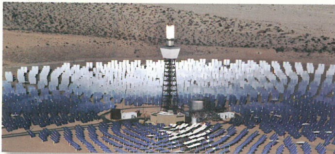
Figura 12.3. Central termosolar de Daggett que produce energía eléctrica a partir de la radiación solar.
