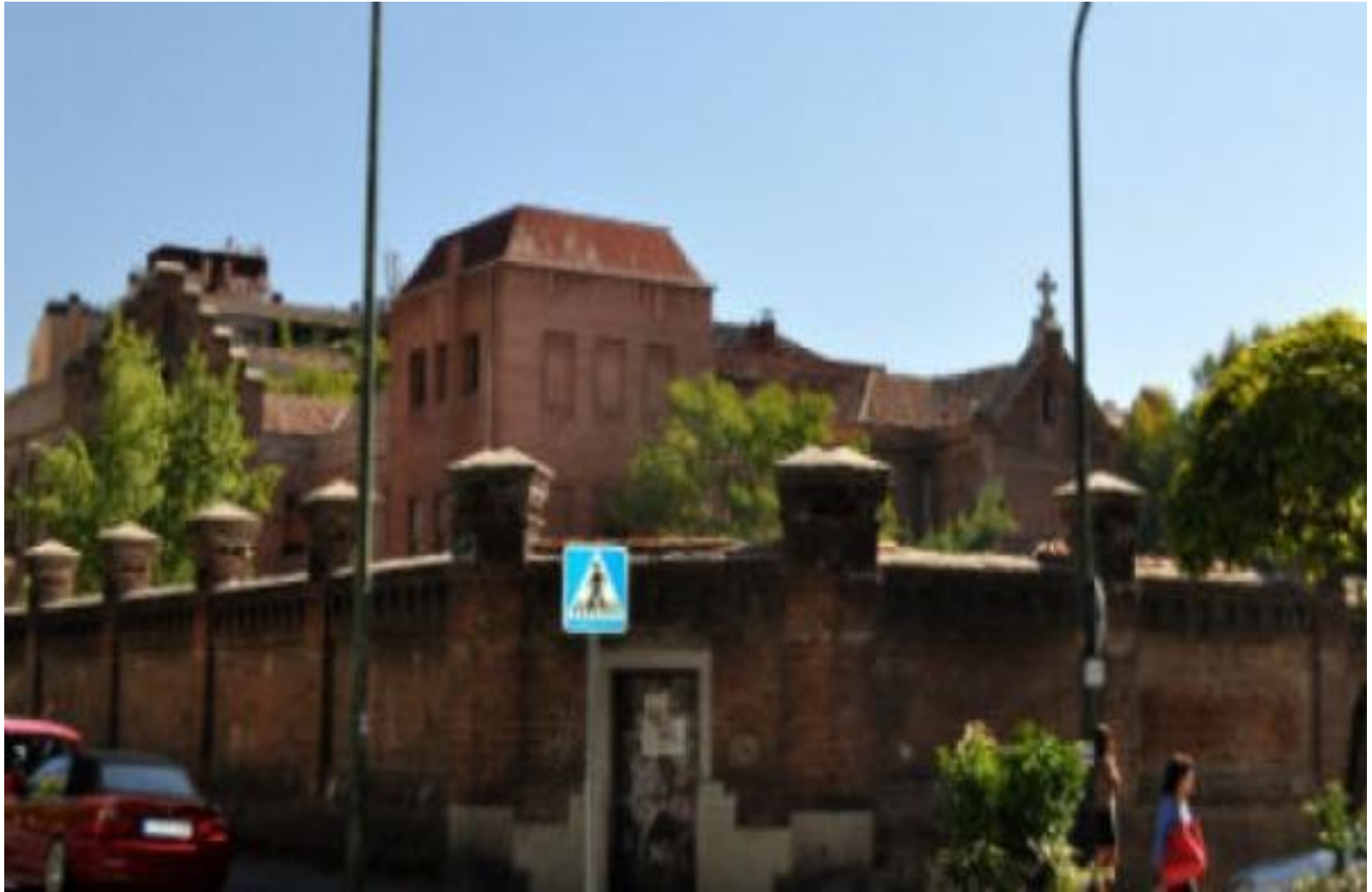
CÁRCEL DE YESERÍAS EN MADRID , A ÚLTIMA NA QUE LUÍS COSTA ESTIVO PRESO E DA QUE TAMÉN CONSEGUIU FUXIR. EN MARZO DE 1949.
