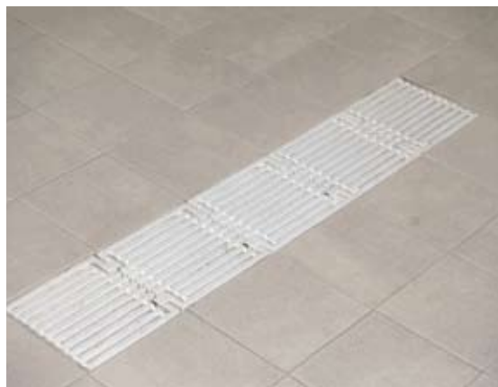
Pavimento de gres.
