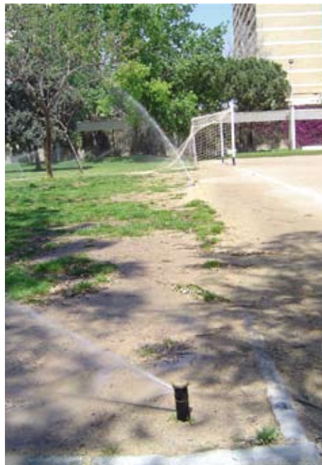
Riego de pradera de césped con aspersores emergentes.
