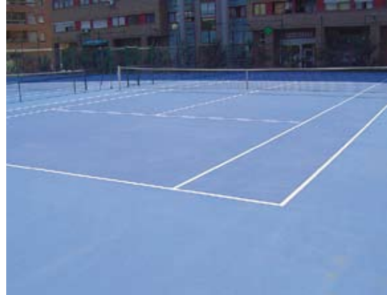
Pavimento de resinas sintéticas sobre asfalto.
