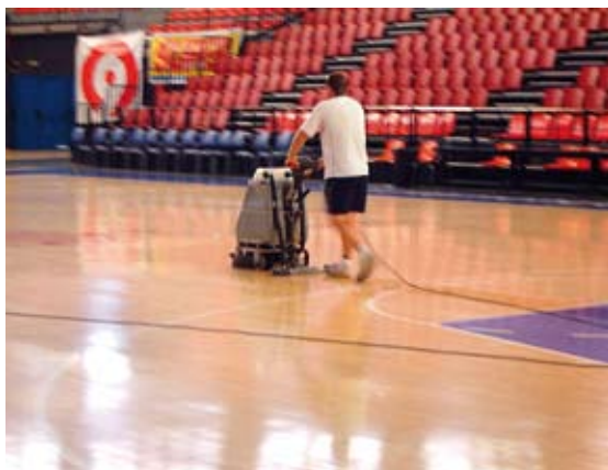
Fregado del pavimento de madera con máquina rotativa y aspiración de agua sobrante incluida.
