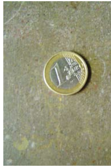
Pavimento de roca sedimentaria.
