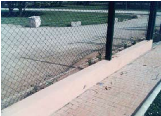
Izquierda y derecha: desperfectos en vallado por golpeo de balón.
