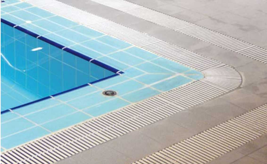
Vaso piscina de hormigón.
