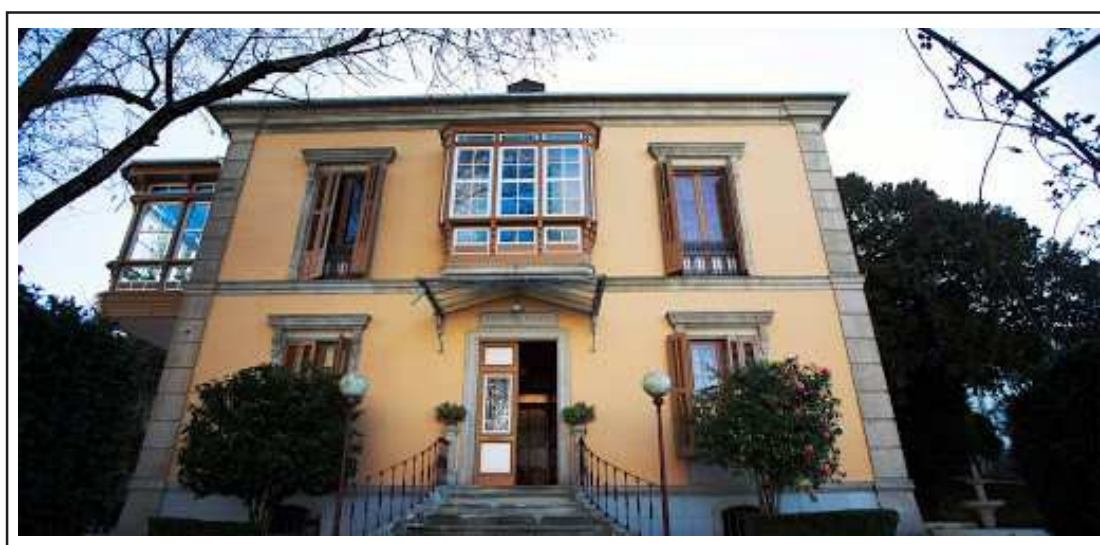
Edificio da Sociedade Cultural La Unión , de Sarria (Lugo)
