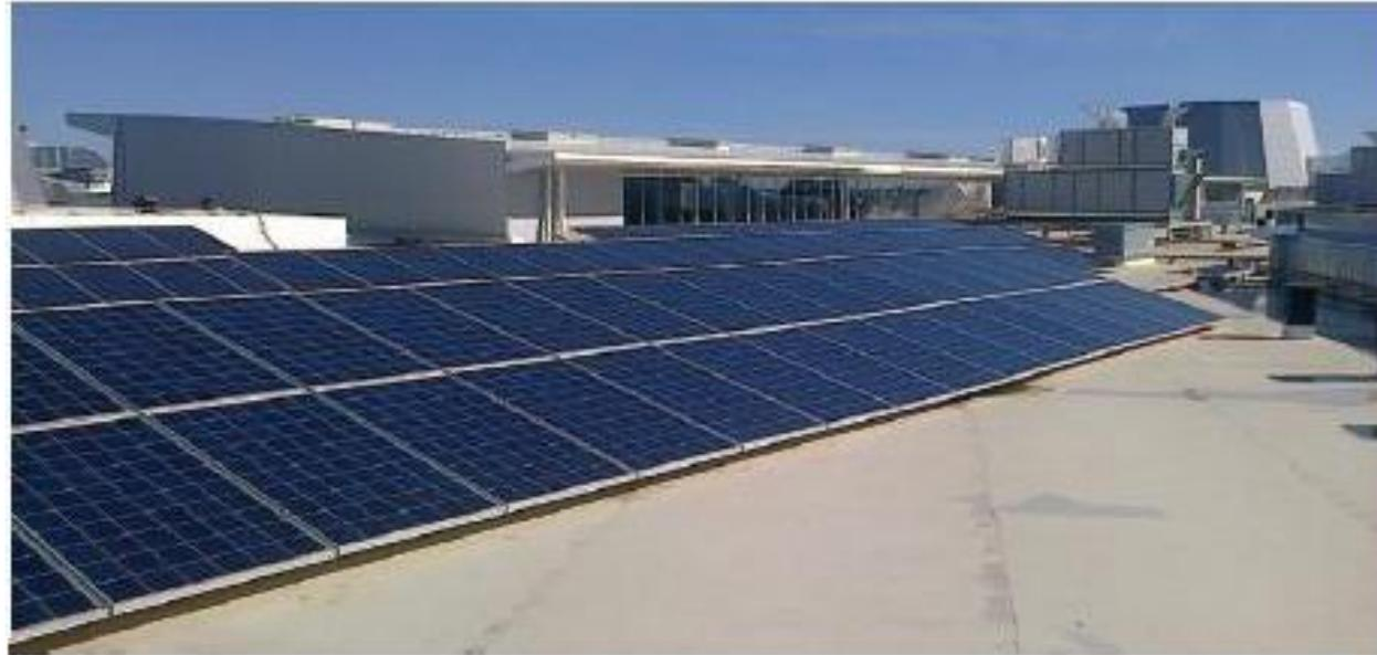
**Figura 4.8.** Paneles formando una cadena de un generador fotovoltaico.
