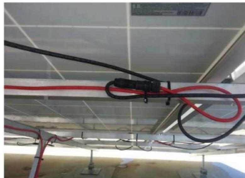
**OJO: No conectar y desconectar en carga. Peligro de arco eléctrico**
