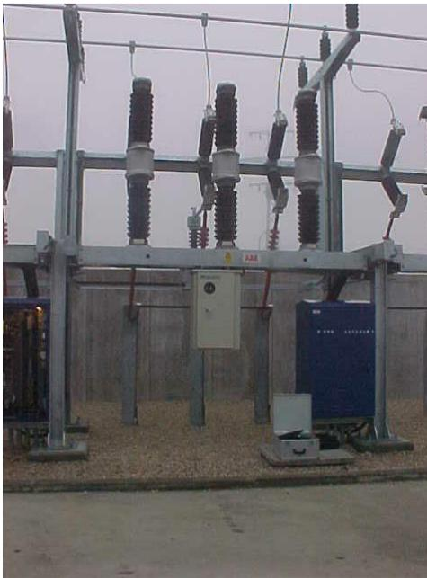
72,5 kV. Montaje exterior. TI's incorporados
