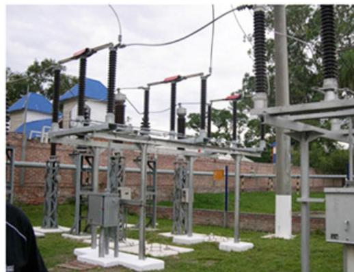
*Seccionadores de cuchillas deslizantes montados en intemperie.*
