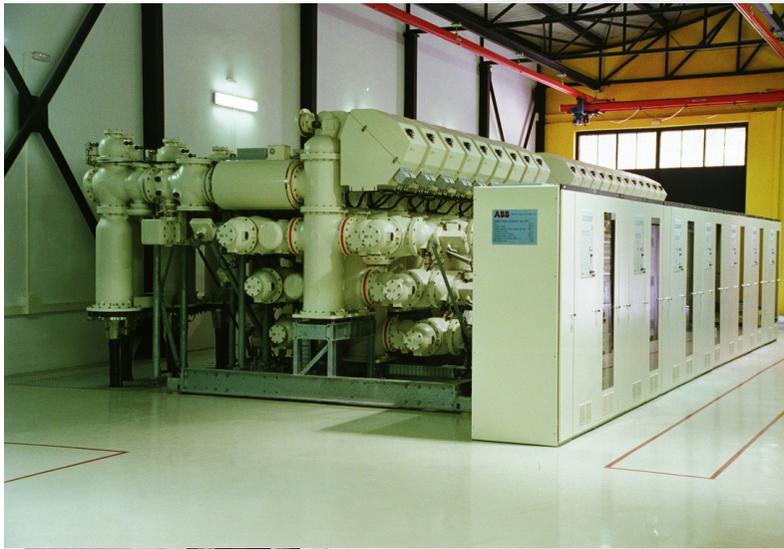
**GIS ABB 220 kV. Aislamiento monofásico
