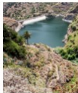
Presa de Mulagua, en Hermigua, La Gomera.
