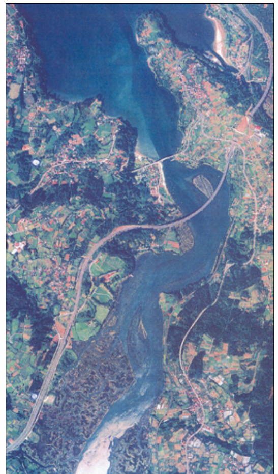
FOTOPLANO DA RÍA DE BETANZOS. (SITGA, CONSELLERÍA DE POLÍTICA TERRITORIAL, OBRAS PÚBLICAS E VIVENDA. ANO 1999).
