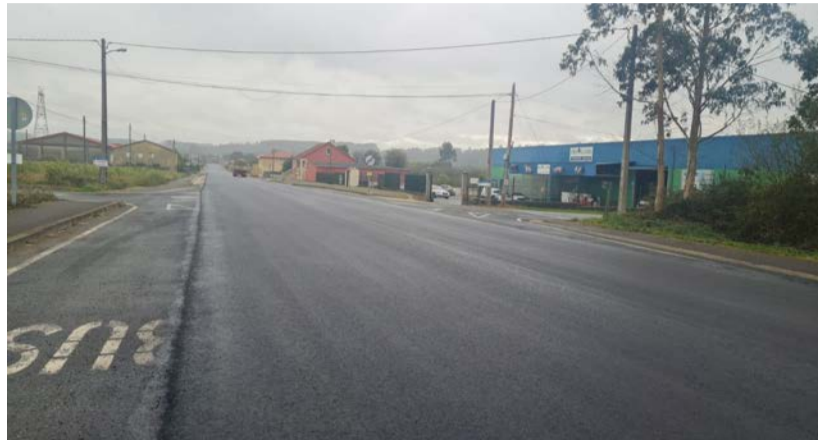
Reparación da estrada Ordes-Lanzá na travesía de Abellá.
