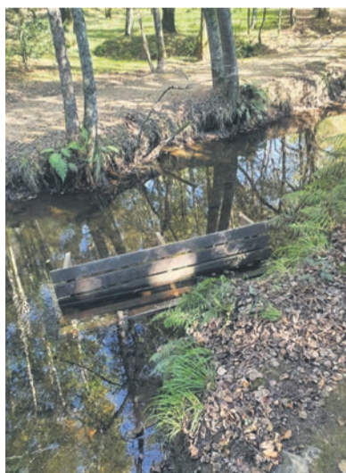
Diversos danos ocasionados no mobiliario do paseo fluvial.
