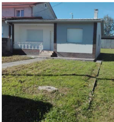
O inmoble, situado en Queirúa, foi acondicionado en 2019.
