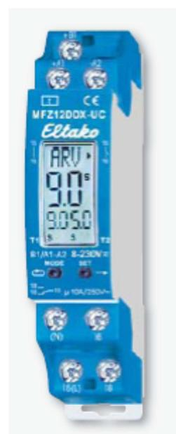
Presionamos MODE repetidamente hasta posicionarnos en el primer dígito del contador de tiempo. Una vez situados en él, pulsamos SET hasta subir el contador a 4 horas y finalizamos con MODE de nuevo. El display marcará 4.0 Horas, que es nuestro tiempo de carga.
