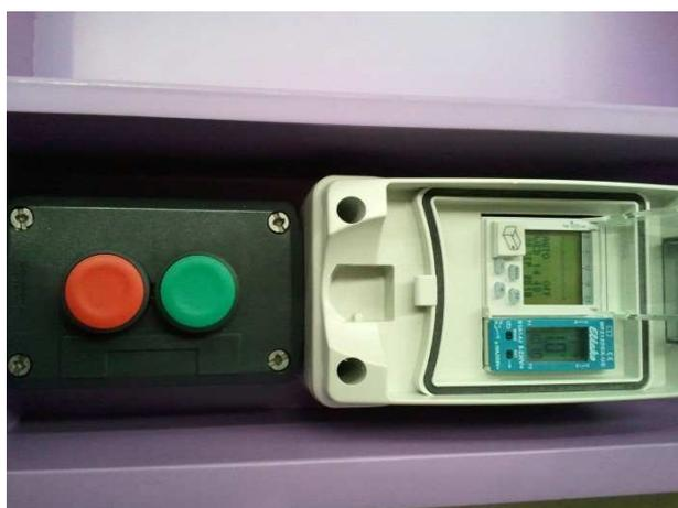
Ubicado al lado del programador, en el cajón superior, se encuentra el configurador del tiempo de carga.
