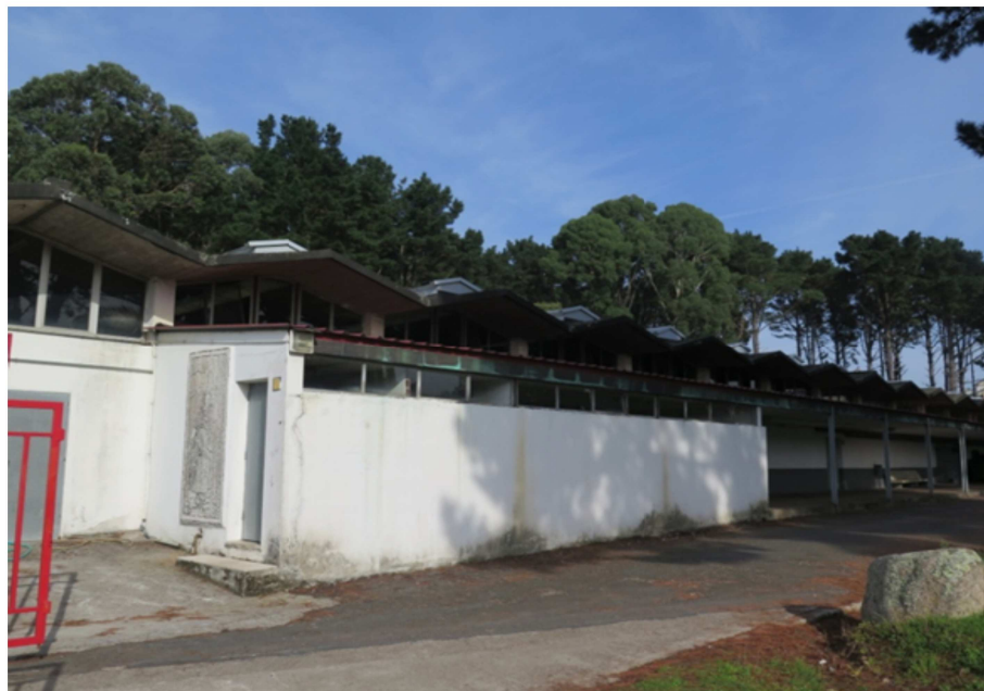
Estado previo: Vista exterior.
