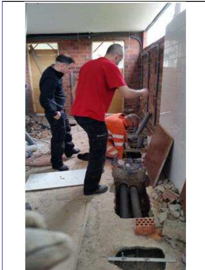
Montaxe do sistema dobre de saneamento para a separación de augas grises e negras.
